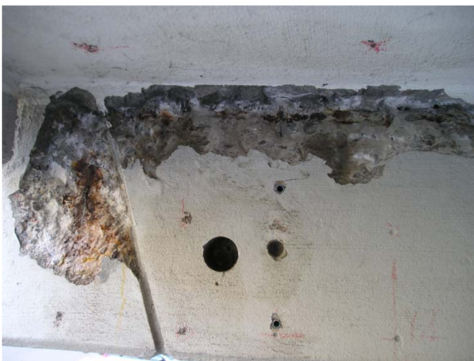
Foto 9: Borekerne 4 er udtaget her. Ophugning 1 pågår. Chloridprøve 3A og 4A er udtaget til højre herfor.
