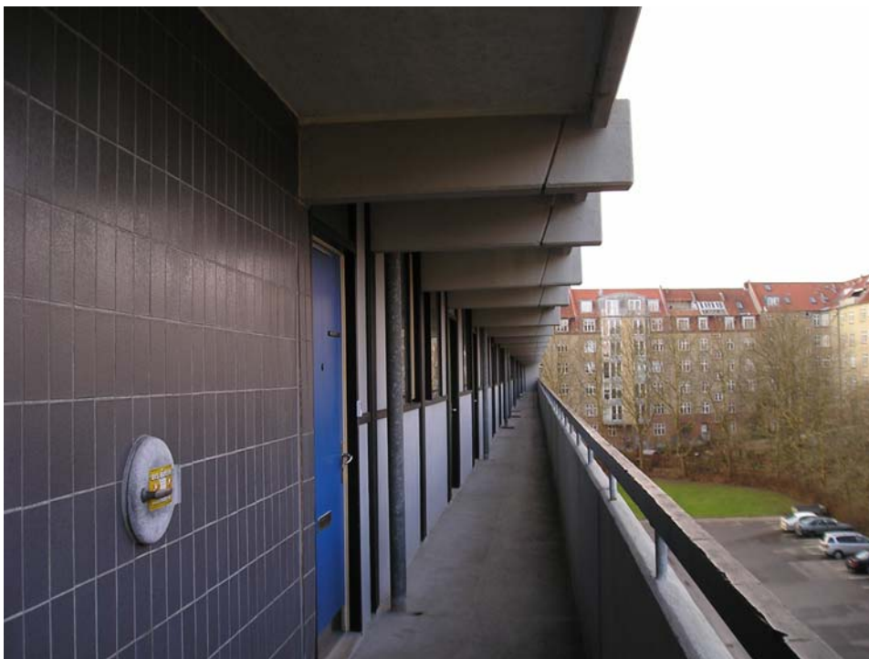
Foto 1: Altangang med udkragede altaner.
