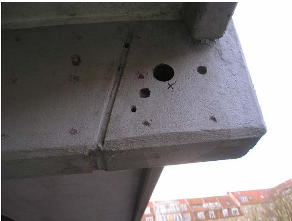
Foto 10: Borekerne 5 er udtaget her. Chloridprøve 7A og 8A er udtaget til venstre herfor.
